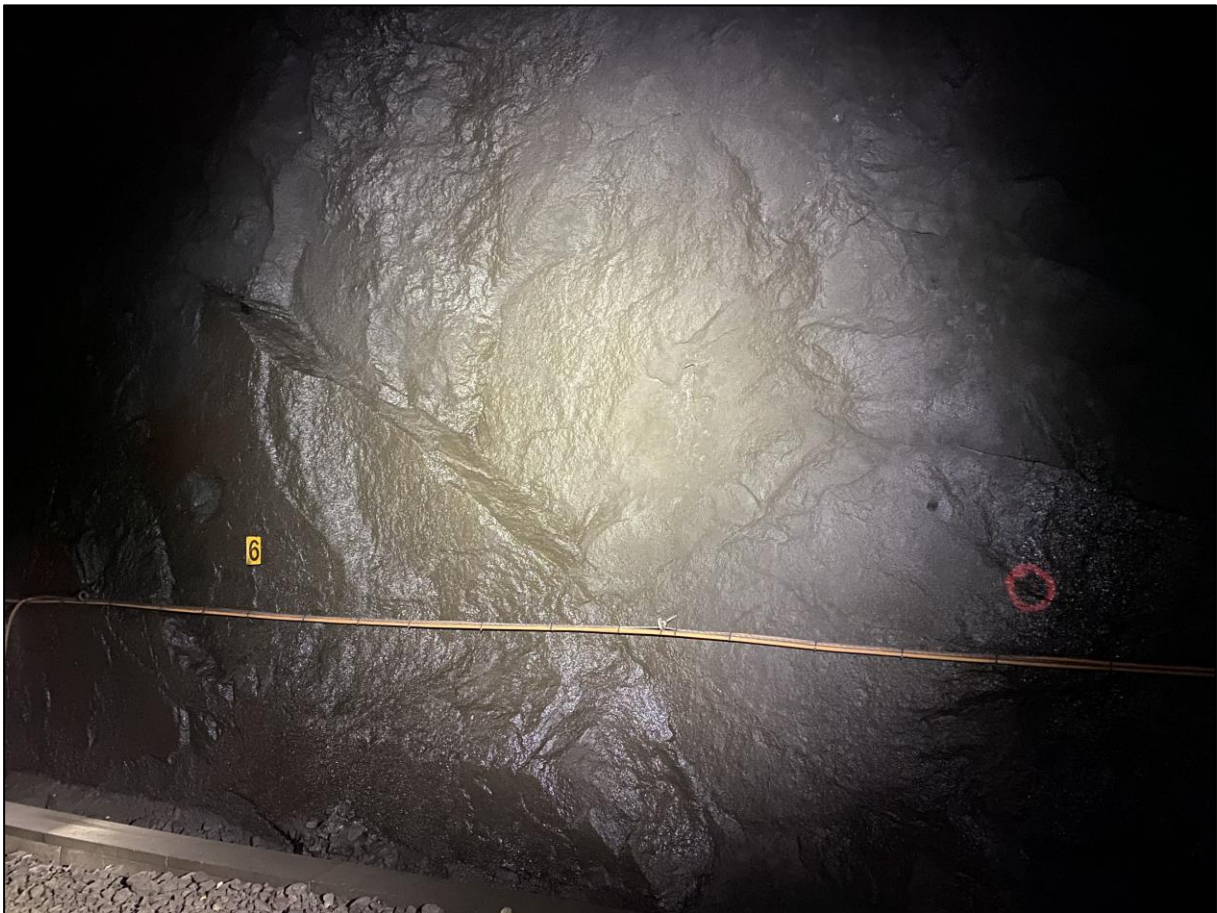
Figur 3-16. Massivt berg i jernbanetunnelen.
