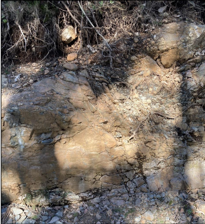
Figur 3-15: Parti med rustutfelling vest for Bjørndalen.
