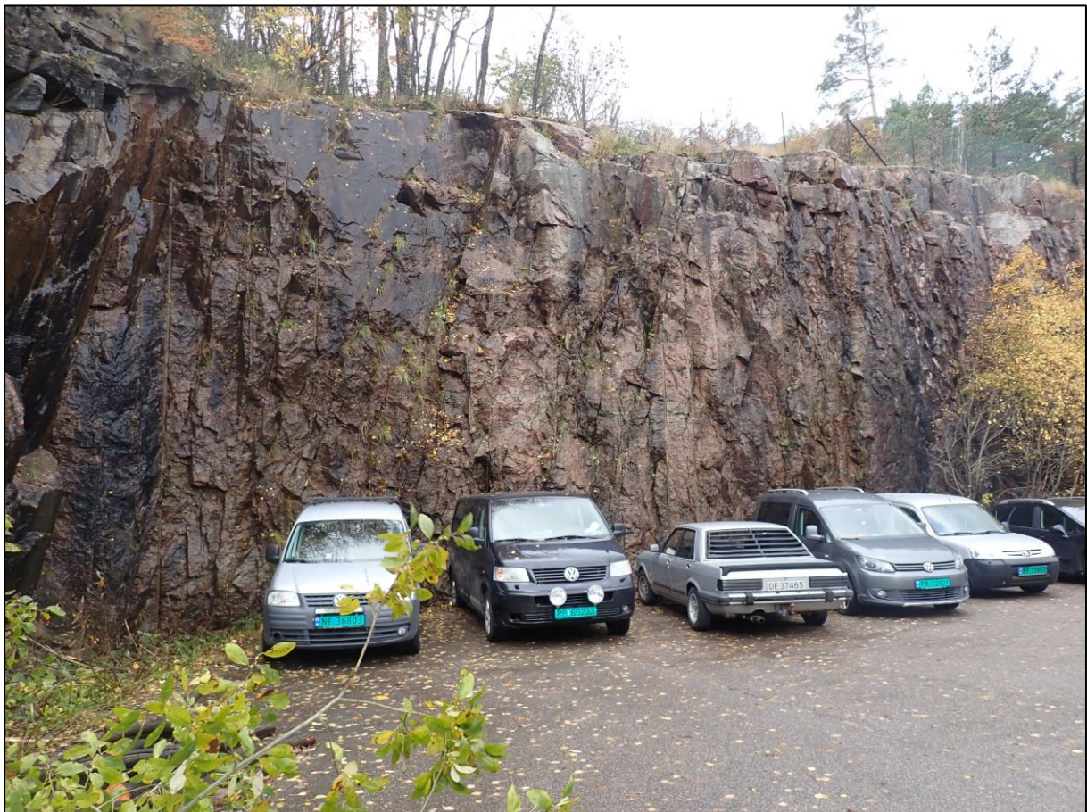
Figur 4-9: Eksisterende skjæring ved Vige Havnevei 6. Skjæringen ligger ca. 60 m øst for påhuggsflaten. Bilde tatt mot vest.
