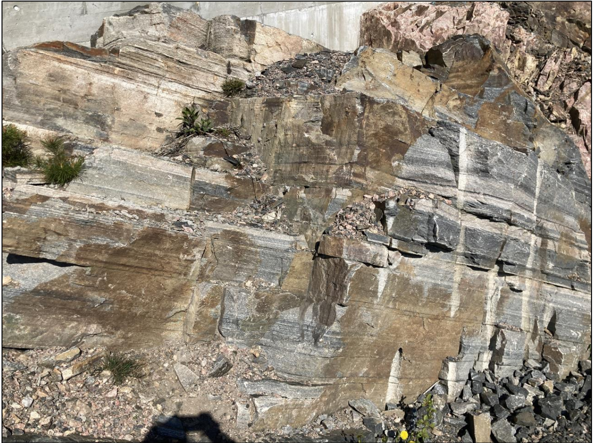
Figur 5-4: Bilde av bergmassen ved brufundament ved eksisterende E18. Bilde tatt mot nord-øst.
