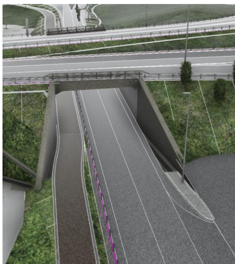
Figur 6-16: Kulvert i Vige, under Ytre ringvei.
