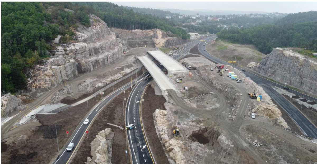
Figur 5-3: Dronefoto av utbyggingen ved Grauthelleren, fra andre kvartal 2023. Bildet er tatt mot nordøst.
