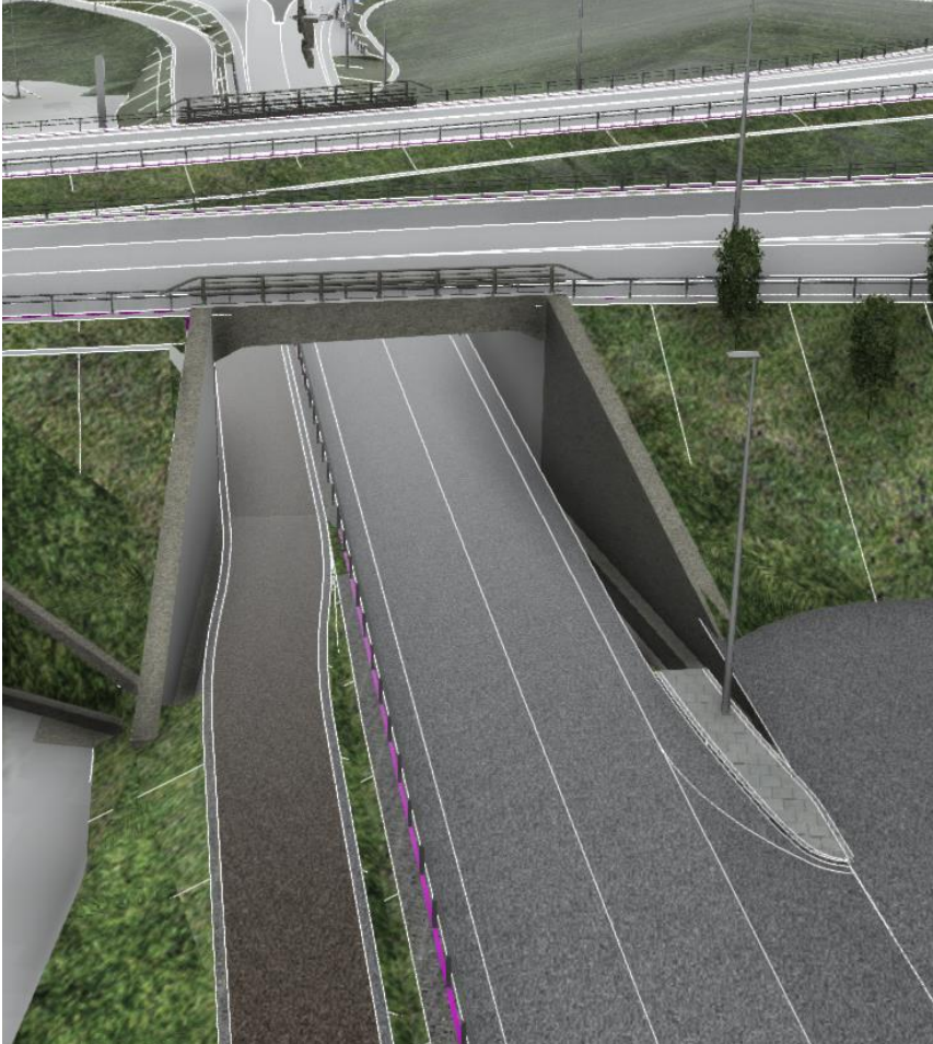
Figur 5-2: Kulvert i Vige under Ytre ringvei.
