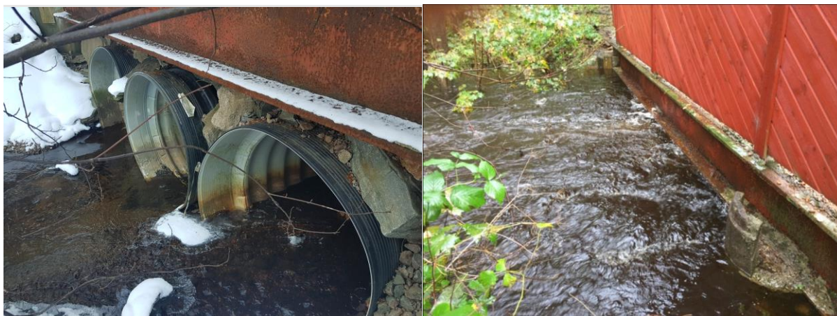
Figur 6-5: Utløpet av kulvertsystemet i en normal situasjon (11.02.2021) og under flommen 02.10.2017 [16].
