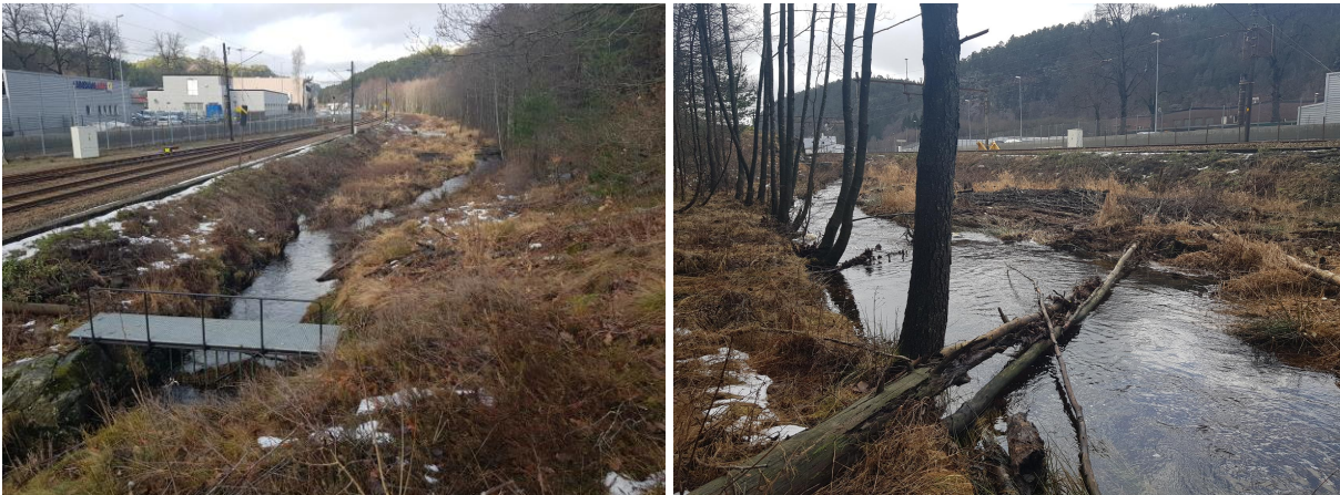
Figur 6-3: Grimsbekken oppstrøms kulvertinnløpet.
