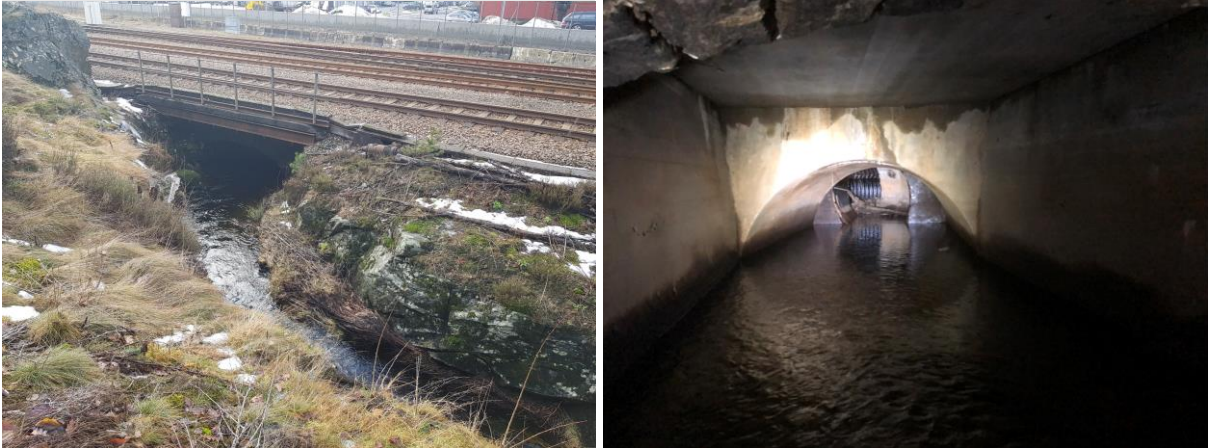
Figur 6-2: Innløpet til lukket kulvertssystem under jernbanen (til venstre). Kobling til kulvert med dimensjon 1700 mm etterfulgt av en sving mot venstre nedenfor jernbanebrua [16].
