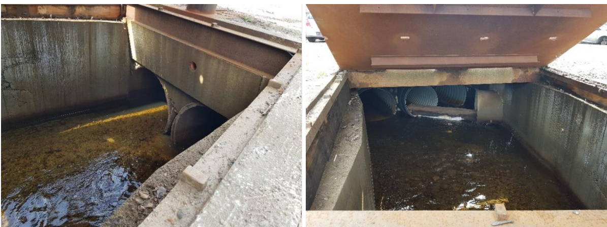
Figur 6-4: Kulvertinnløp for Grimsbekken i kummen under Dalaneveien 35 (til venstre). Grimsbekken renner videre i tre stålkulverter med \varnothing 1000 mm (til høyre).
